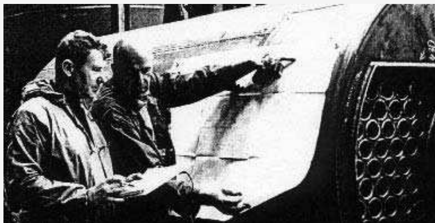
Проверка соответствия котла Vitomax технической документации
