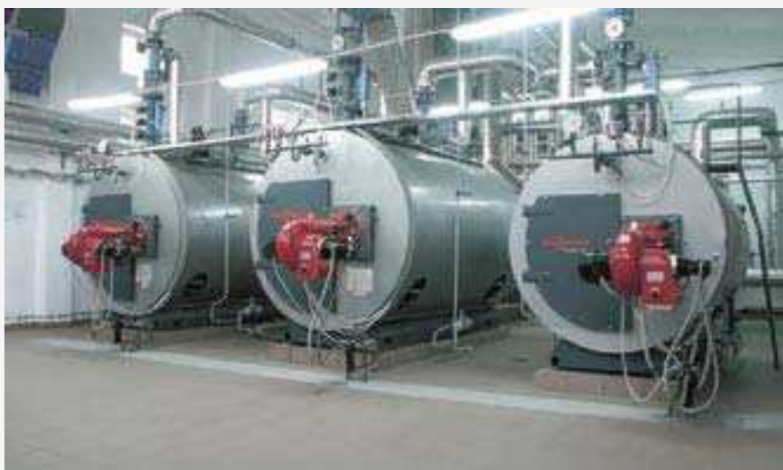
Vitomax 200 HW 2600-14000 кВт Трехходовая конструкция котла с возможностью установки тележки для монтажа горелки — максимально до 6500 кВт
