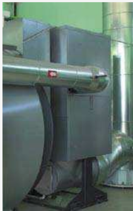
Водогрейный котел серии Vitomax 200, оснащенный экономайзером Vitotrans 333
